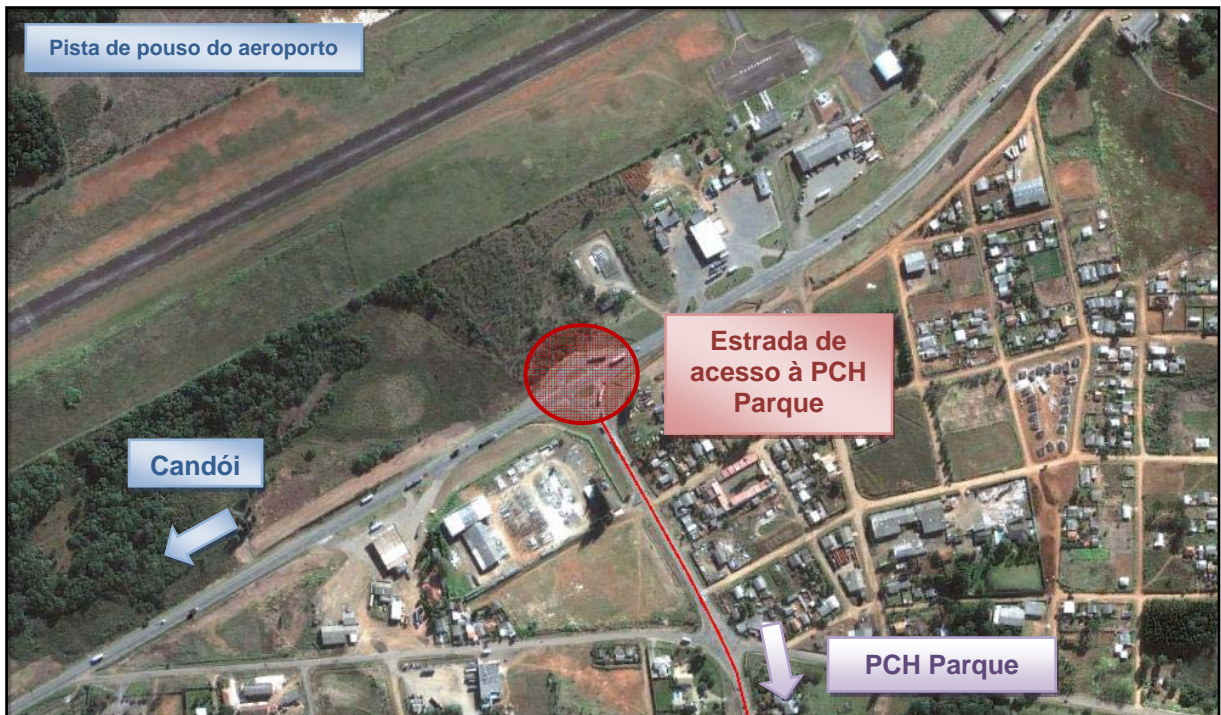
Figura 2-6: Acesso à estrada que leva ao local de implantação do empreendimento.
