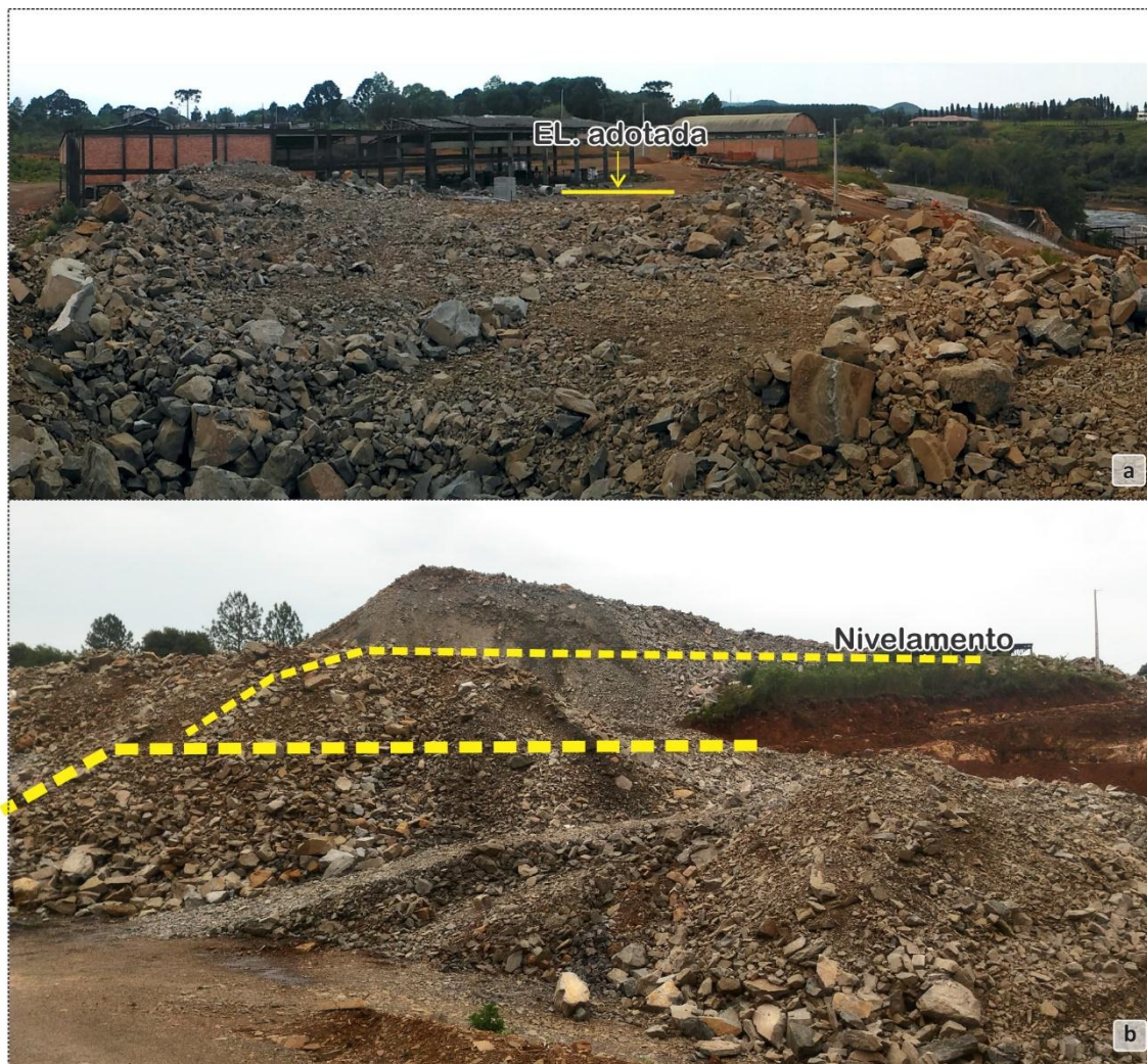
Figura 7 - [a] Elevação a ser adotada no primeiro estágio do nivelamento. [b] Perspectiva do nivelamento.
