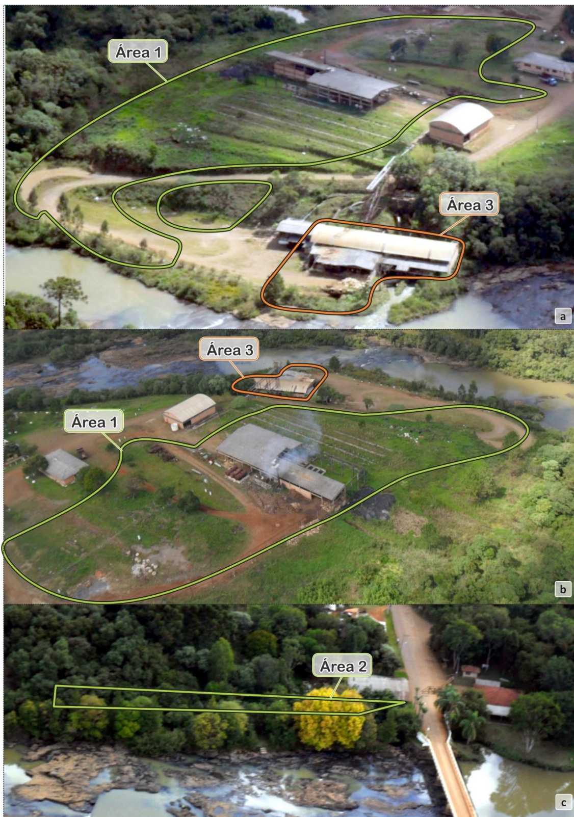
Figura 2 – Registro fotográfico das áreas antes do início das obras. (Adaptado do RAS CGH Parque. Fotos de 2016).
