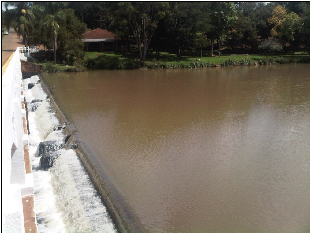
Figura 0-25: Barramento e reservatório – ambos existentes.
