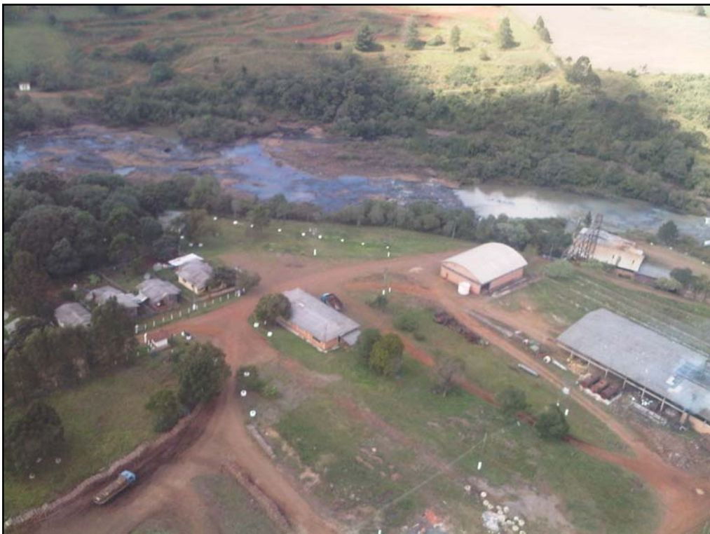
Figura 0-8: Margem direita do rio Jordão, próximo à casa de força.
