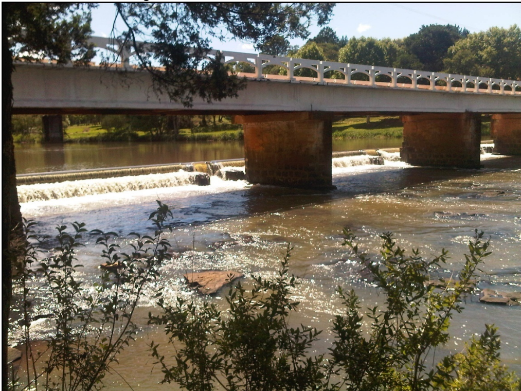
Figura 0-23: Vista do barramento existente.
