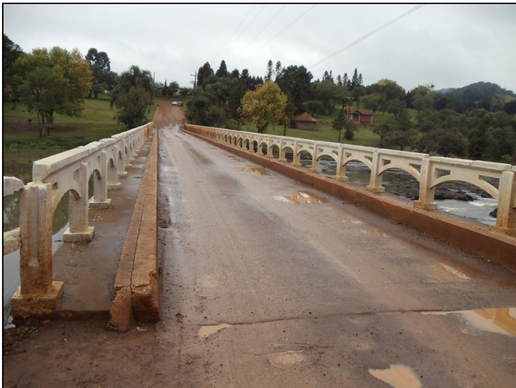
Figura 0-64: Ponte sobre o barramento.
