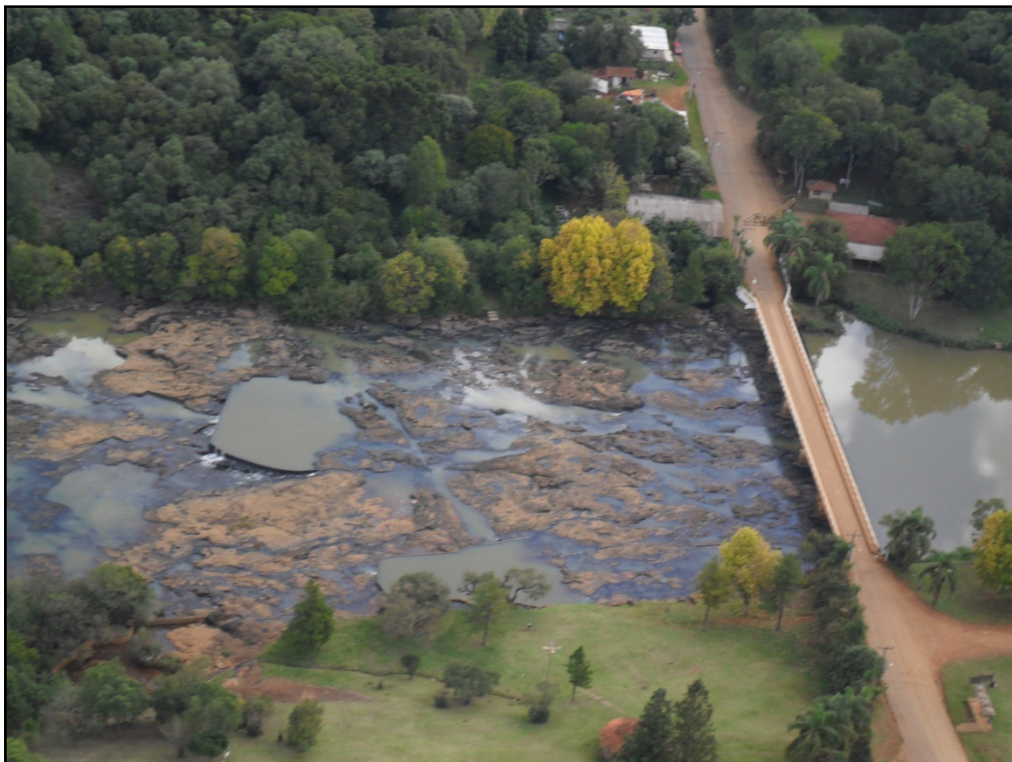
Figura 0-14: Barramento e reservatório da PCH Parque.
