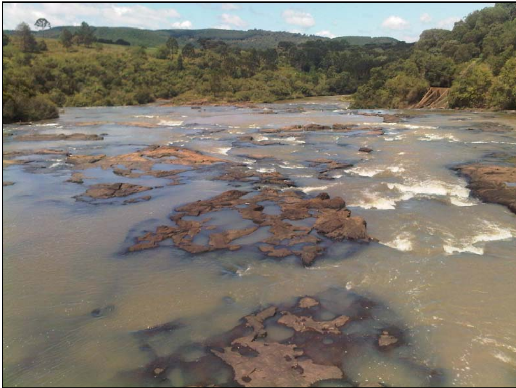
Figura 0-20: Vista a jusante do barramento.
