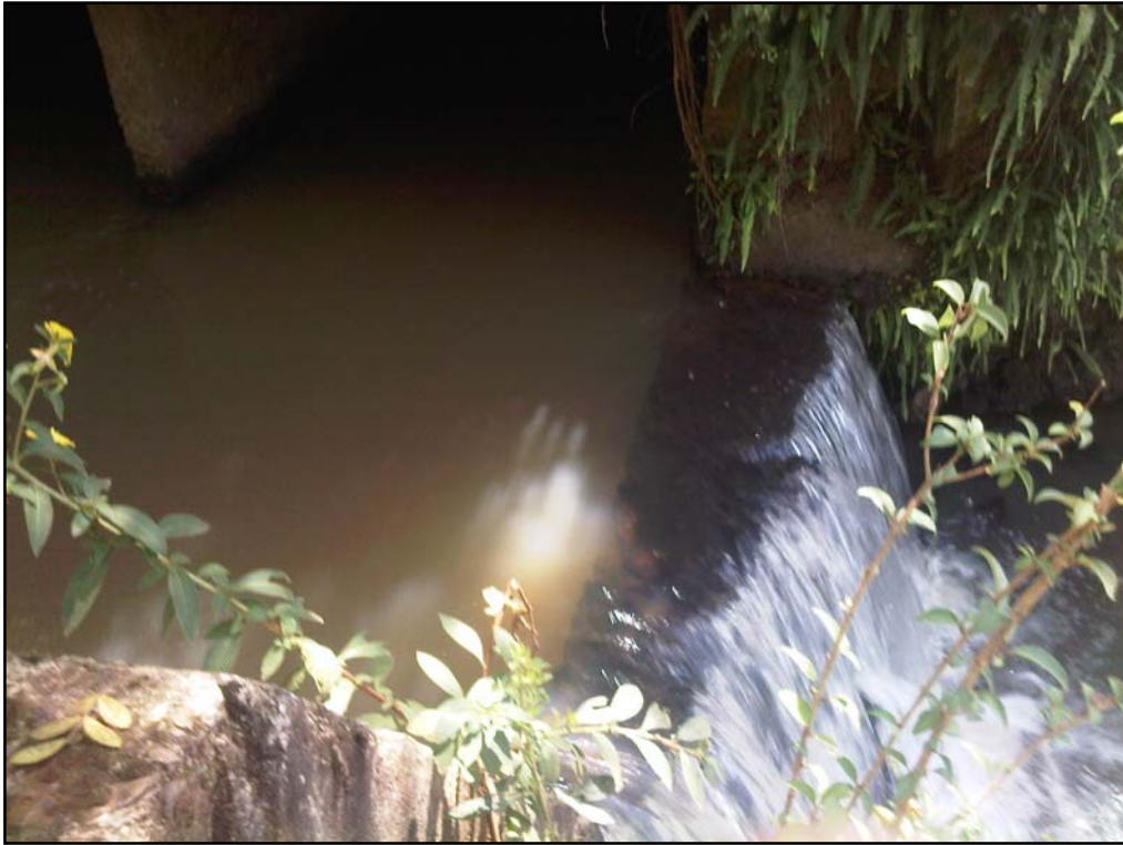
Figura 0-24: Detalhe da tomada d'água existente.
