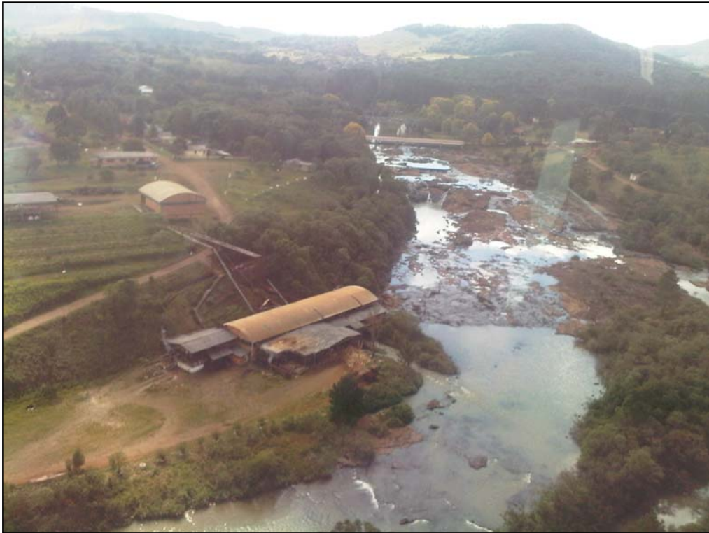
Figura 0-9: Casa de força da PCH Parque.
