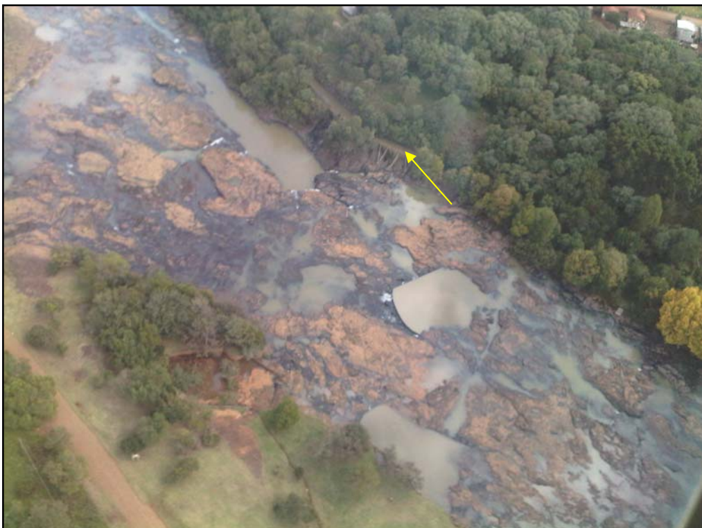
Figura 0-6: Trecho a jusante do barramento. No detalhe está o canal adutor da PCH Parque.
