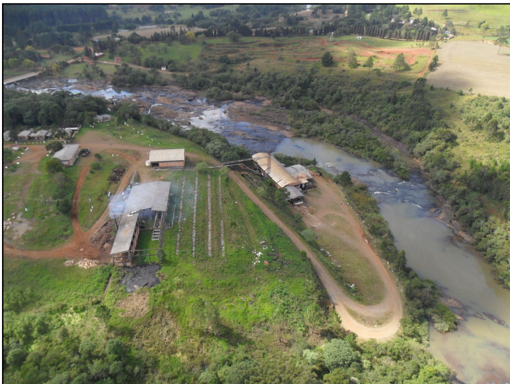
Figura 0-16: Margem direita do rio Jordão, próximo à casa de força.
