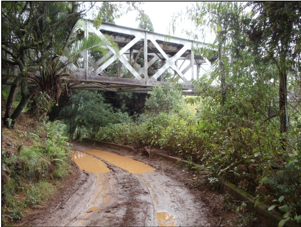
Figura 0-69: Acesso ao Parque Jordão.
