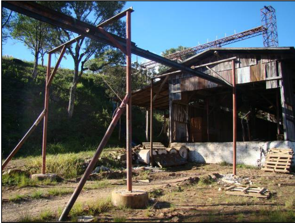
Figura 0-54: Área antrópica (construções) na ADA da PCH Parque.
