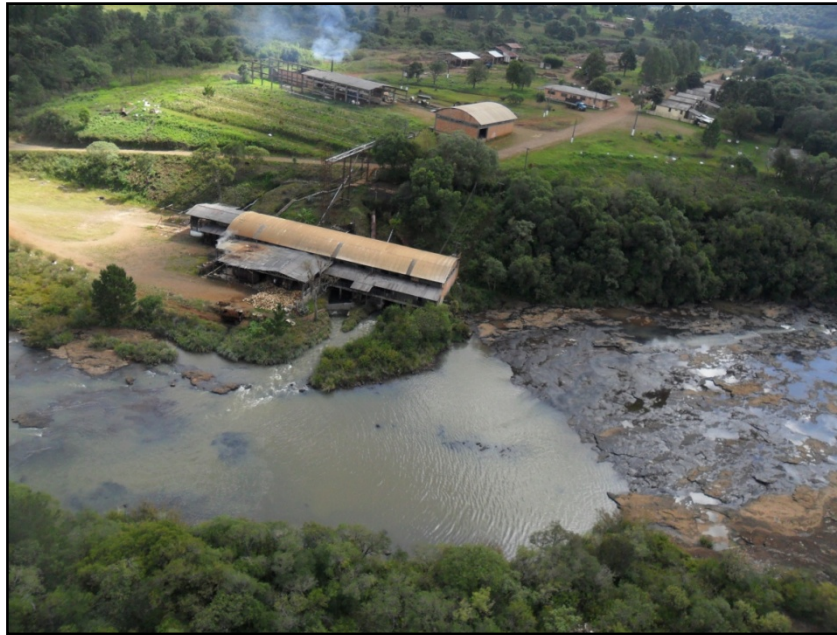
Figura 0-17: Local de implantação da casa de força da PCH Parque.
