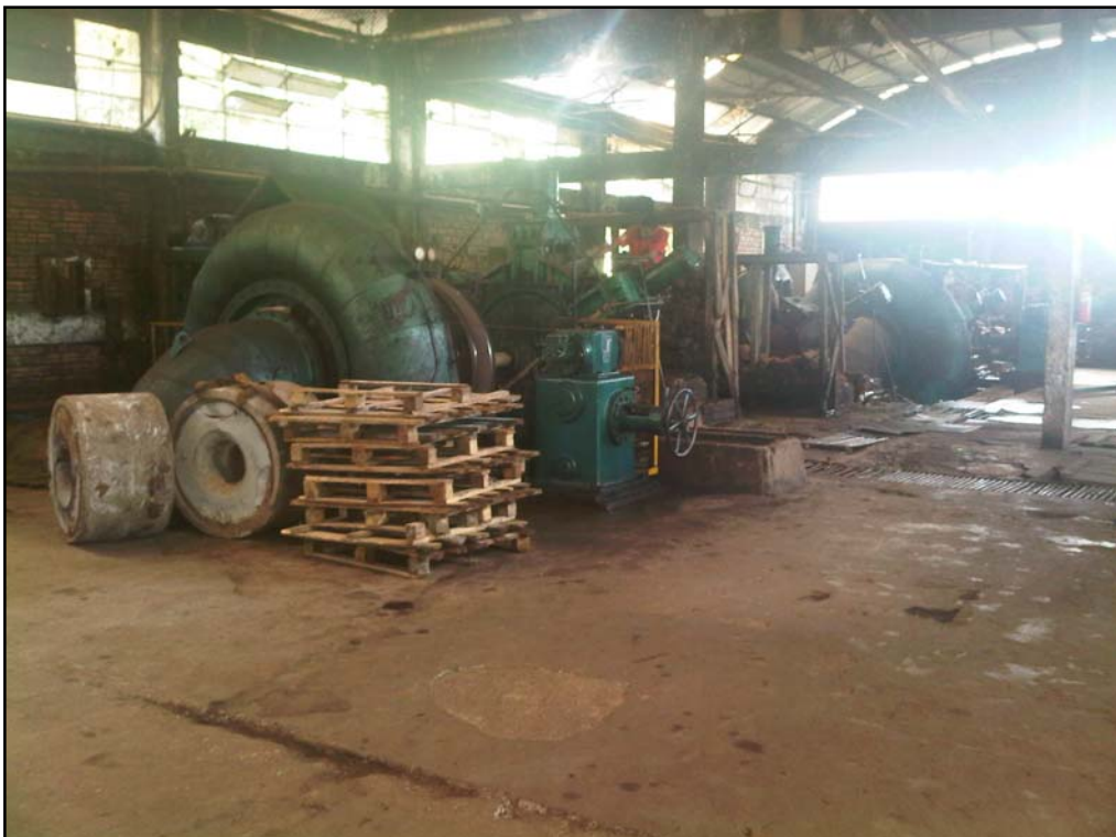
Figura 0-28: Casa de máquinas existente (fábrica de pasta mecânica).
