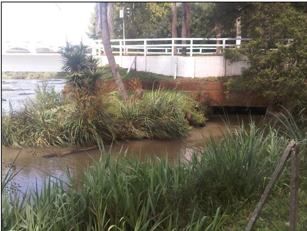
Figura 0-26: Canal adutor existente.
