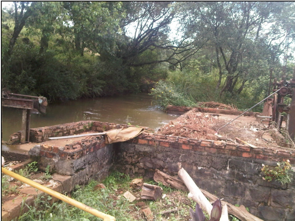
Figura 0-27: Câmara de carga existente.
