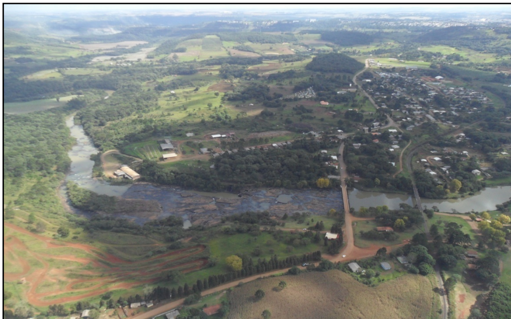
Figura 0-2: Vista do barramento e do reservatório da PCH Parque.
