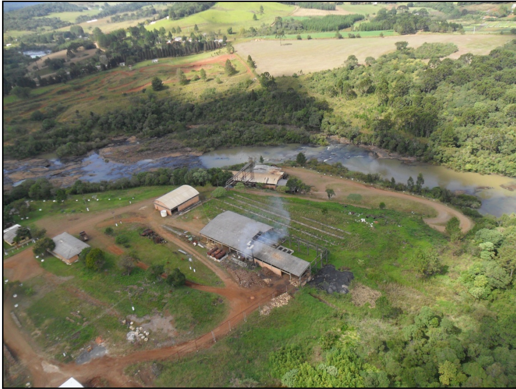
Figura 0-15: Margem direita do rio Jordão, próximo à casa de força.
