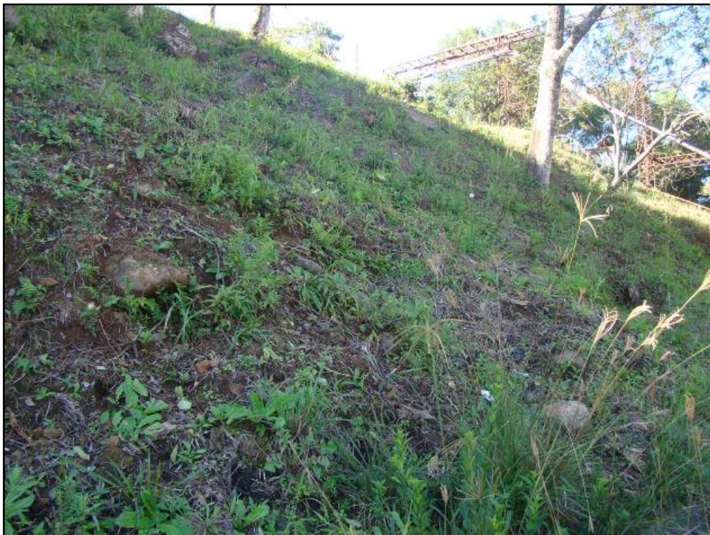
Figura 0-55: Talude na ADA da PCH Parque.
