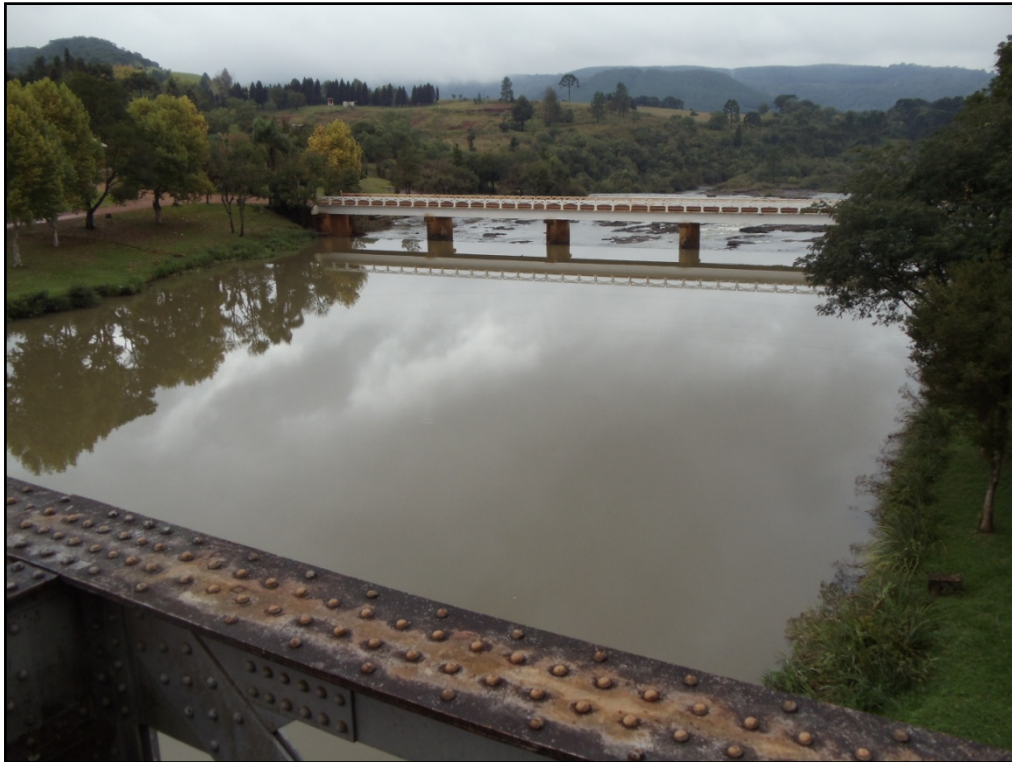
Figura 0-63: Ponte sobre o barramento.
