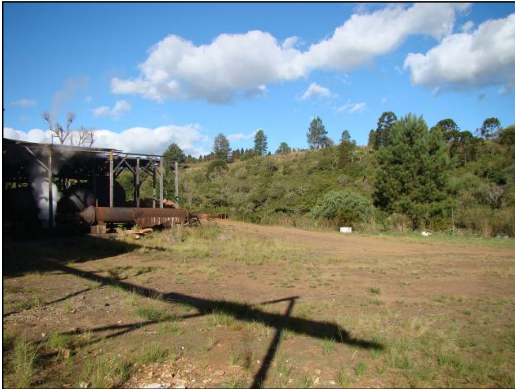
Figura 0-50: Área de solo exposto na AID da PCH Parque.
