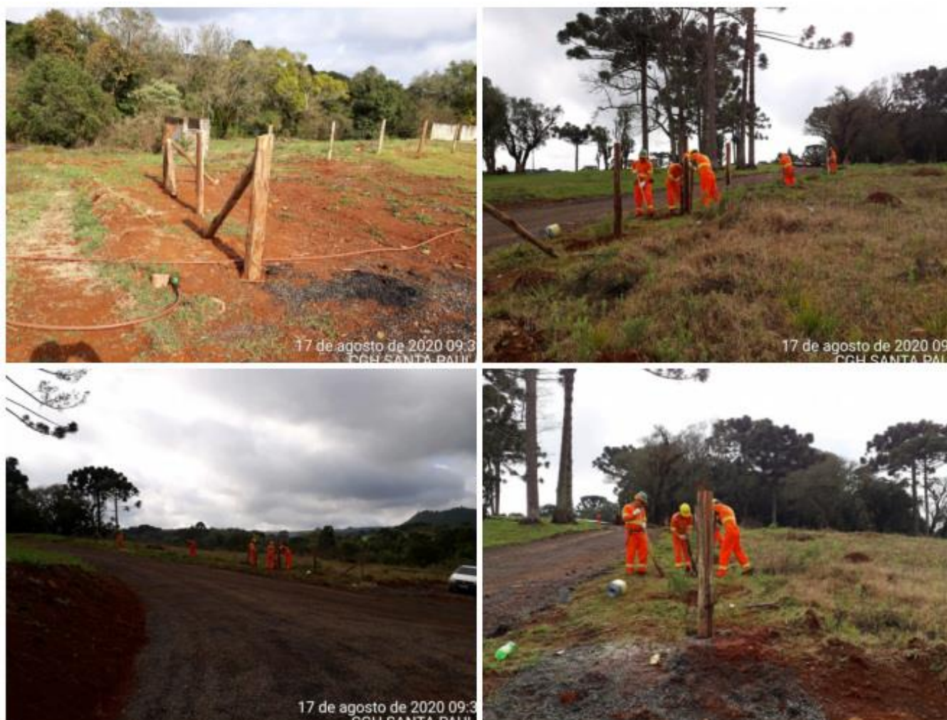
Figura 8 - Cercamento da área para compensação do empreendimento.
